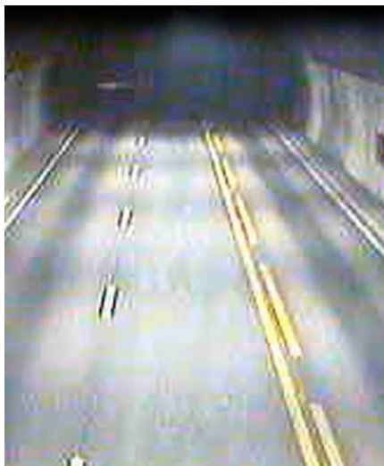
Figur 5.3: Røyk i tunnelen. Foto: Utklipp fra videoovervåking i tunnelen - Statens vegvesen
